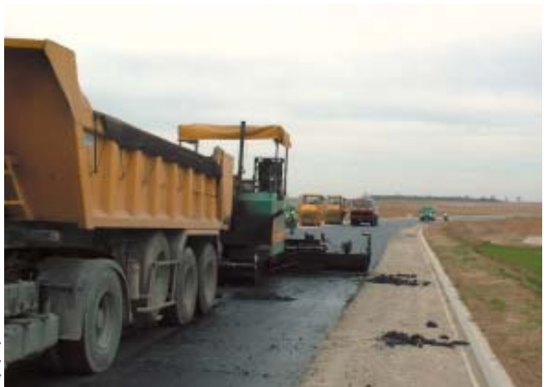
Mise en œuvre d'un BBTM
