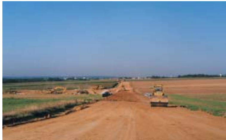
Terrassements dans des sols limoneux
