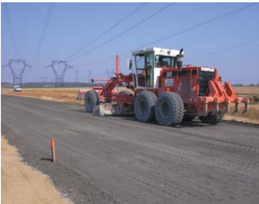
Mise en œuvre d'une couche de fondation en sable traité
